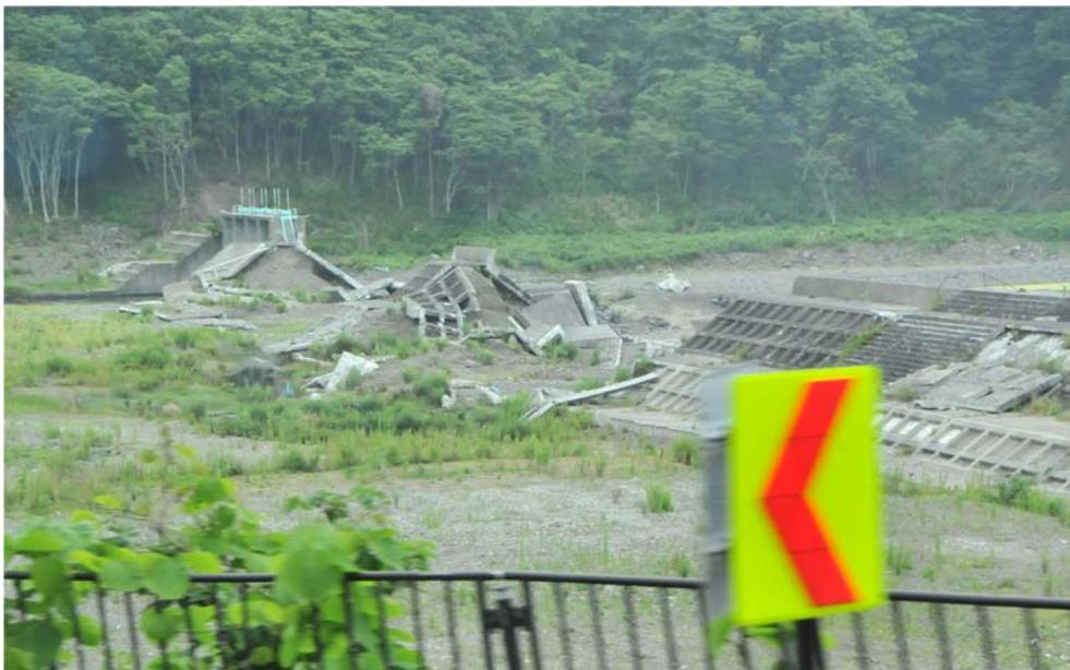
破壊された防潮堤（田野畑漁港）
