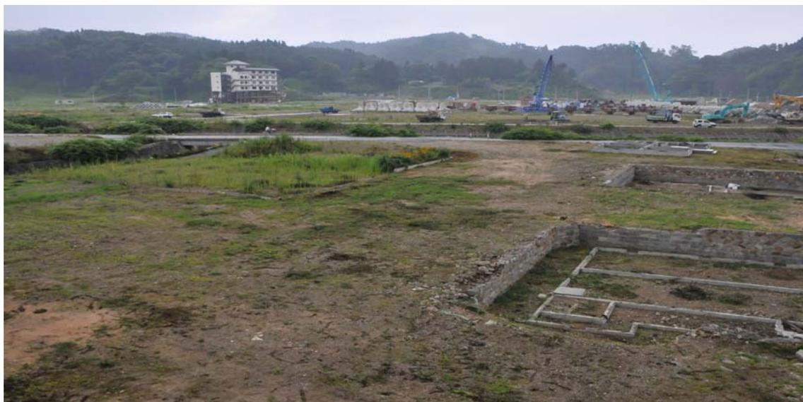
第一防潮堤の海側，第二防潮堤が出来る以前は，砂浜であったが，三陸鉄道トンネル掘削屑などで埋め立てられて，いつの間にか住宅地となり今回の津波で完全に流失。左奥の建物，「田老観光ホテル」は，3階まで完全に破壊された。右手奥では消波ブロックの製作と設置作業が行われていた。
