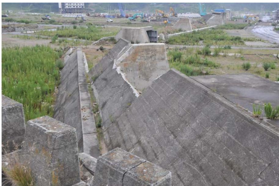
破壊された第二防潮堤（田老漁港）
