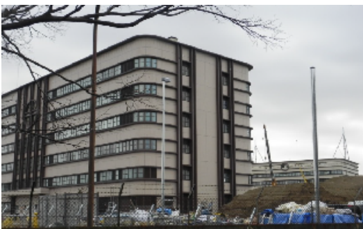
完成間近の司令部棟・キャンプ座間
