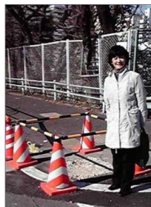
↑09年1月17日、信号設置の工事がはじまった所で近藤区議
