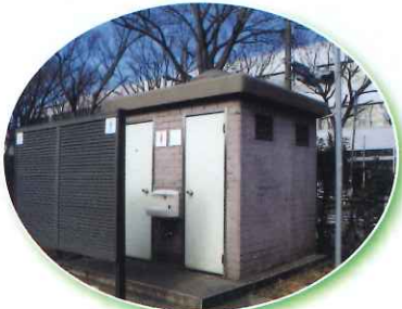
北習志野近隣公園入り口に公衆トイレを設置(平成17年2月)
