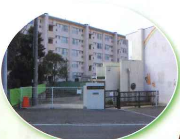
習志野台第二保育園の正門を後退して車庫スペースを確保(平成21年5月)
