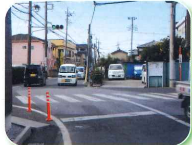
飯山満町3丁目西友そばの交差点を改良し、右折車線を新設し渋滞を緩和します
