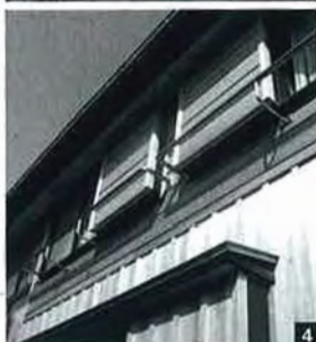
1 築14年の住まい。当時は防火規制のため外壁は中空サイディング。老朽化し、コーキングも劣化。 2 2階は水切りのいい下見板張り。住宅街に落ち着いた風景が生まれた。 3 杉板は厚15mm。無塗装。経年変化で焦げ茶から佗びた銀鼠色に変わる。 4 開口部周りは、増えた厚み分水切りの木枠をつくり、サッシの下に板金を施す。
