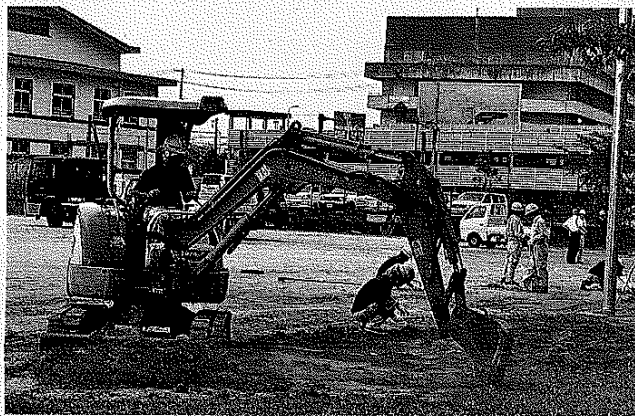
重機を巧みに操って作業を進めた
