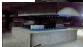
手前の柱が免震工事をしたもの。地下なので露出した状態
